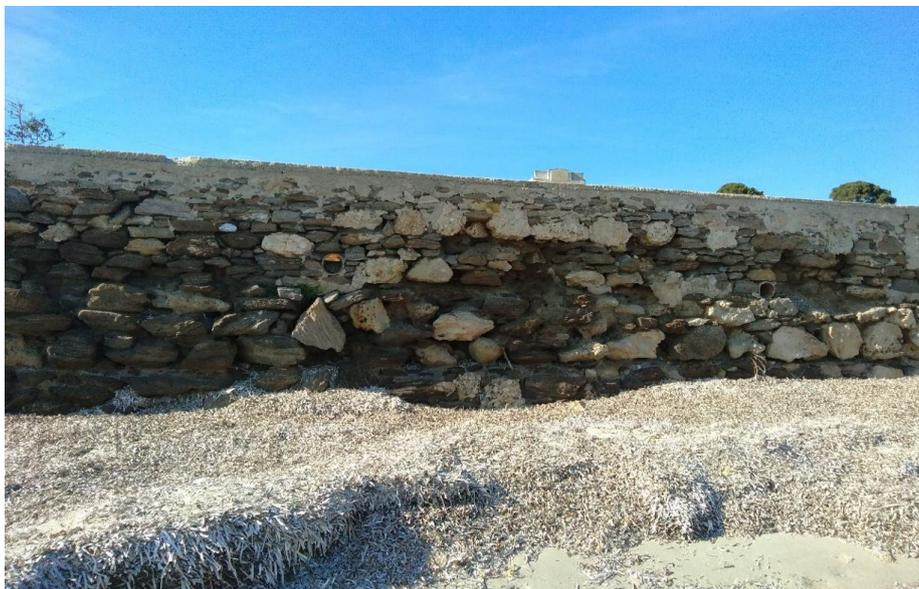
**FIGURA 11. STRADA FORNELLI - CALA D'OLIVA. DETTAGLIO MURO DI CONTENIMENTO LATO MARE.**
