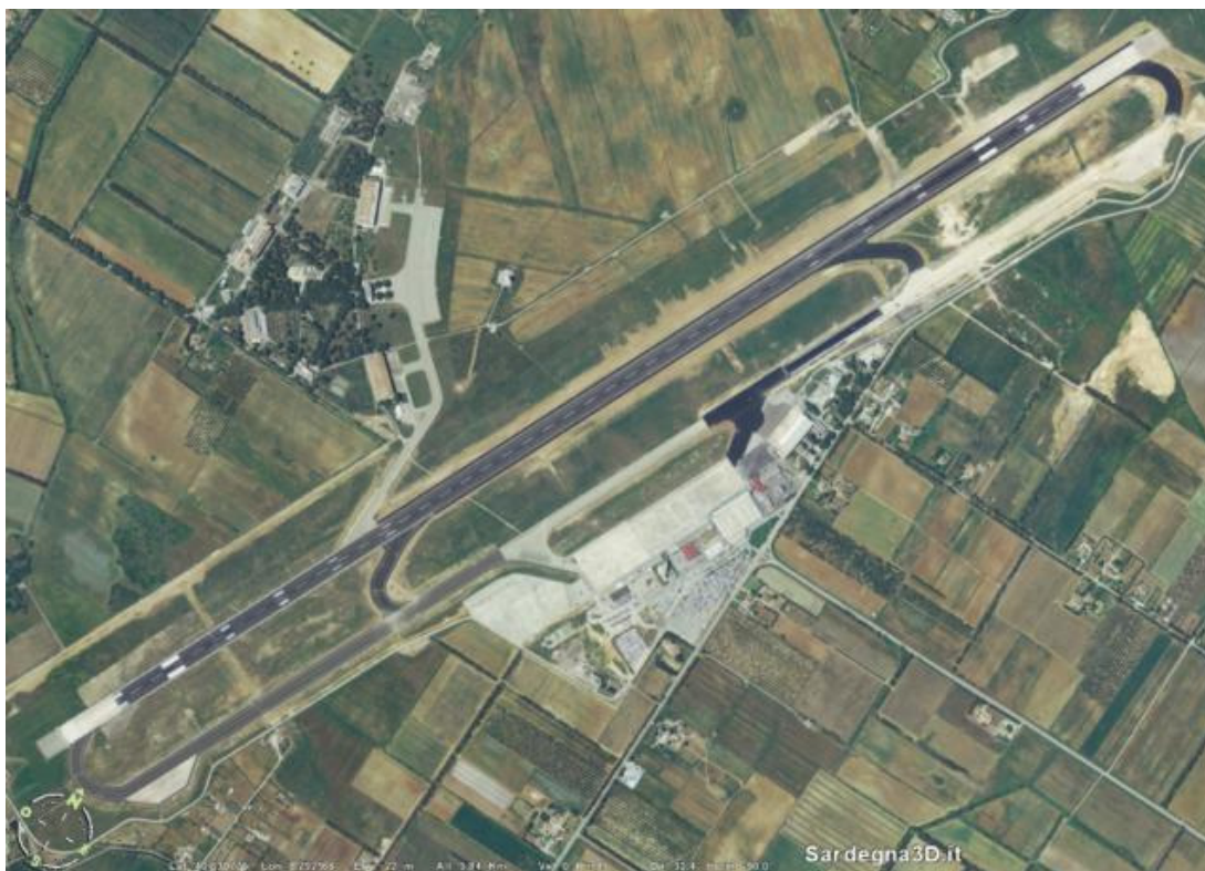
Figura 5.2-4: Veduta dell'aeroporto di Alghero (Fonte: Sardegna 3D)
