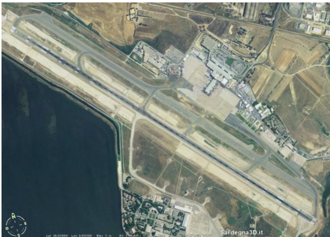
Figura 5.2-2: Veduta dell'aeroporto di Cagliari (fonte: Sardegna 3D)
