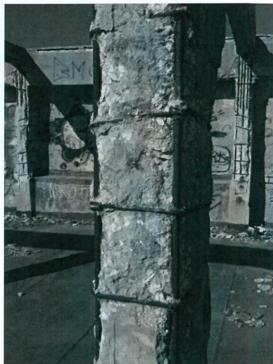
Terrazza di copertura, degrado del portico in calcestruzzo armato
