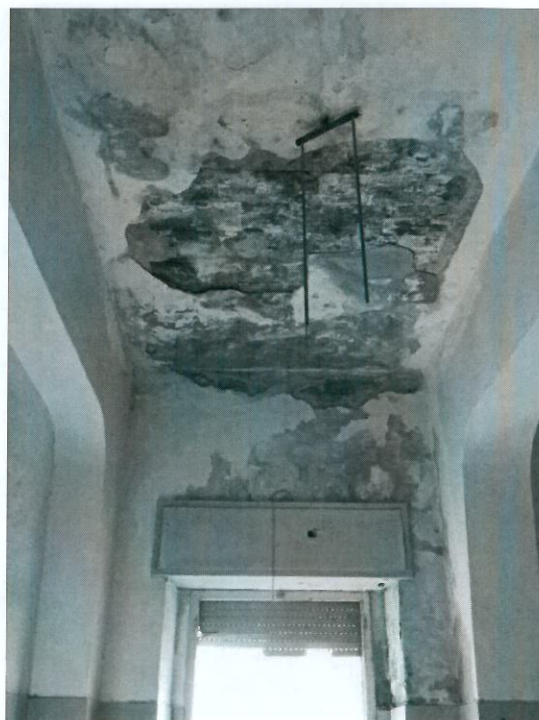
Dettagli del piano primo con evidenza delle condizioni di degrado da infiltrazione
