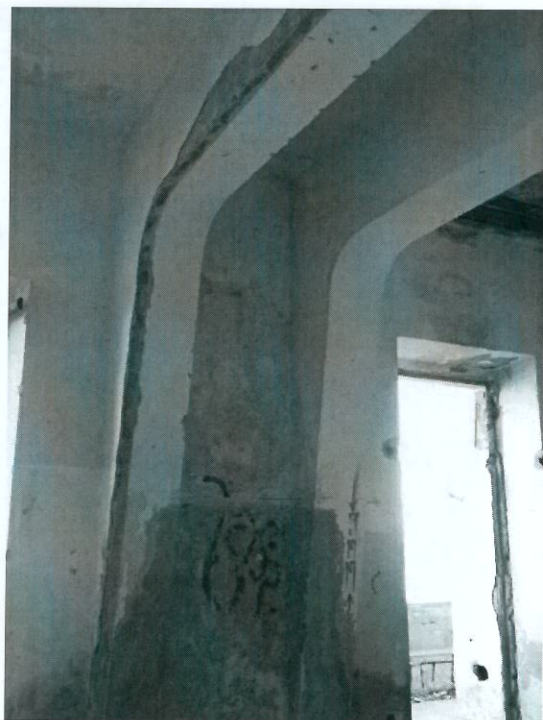
Dettagli del piano primo con evidenza delle condizioni di degrado da infiltrazione
