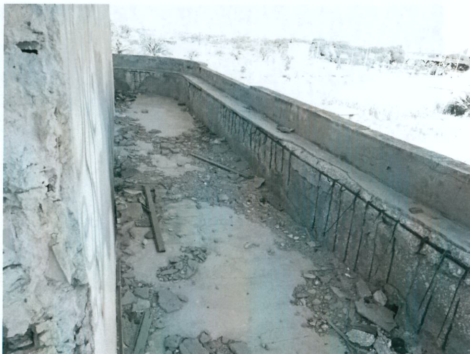
Degrado delle strutture esterne in calcestruzzo armato
