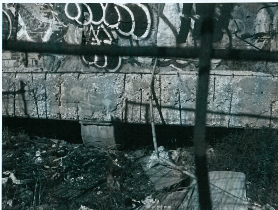
Dettagli delle strutture verso la spiaggia con evidenza del degrado dei calcestruzzi e dell'ossidazione delle armature metalliche
