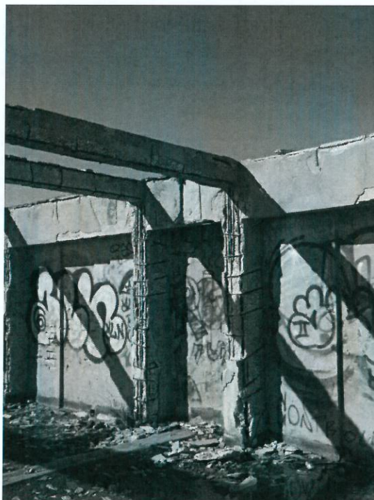
Terrazza di copertura, degrado del portico in calcestruzzo armato
