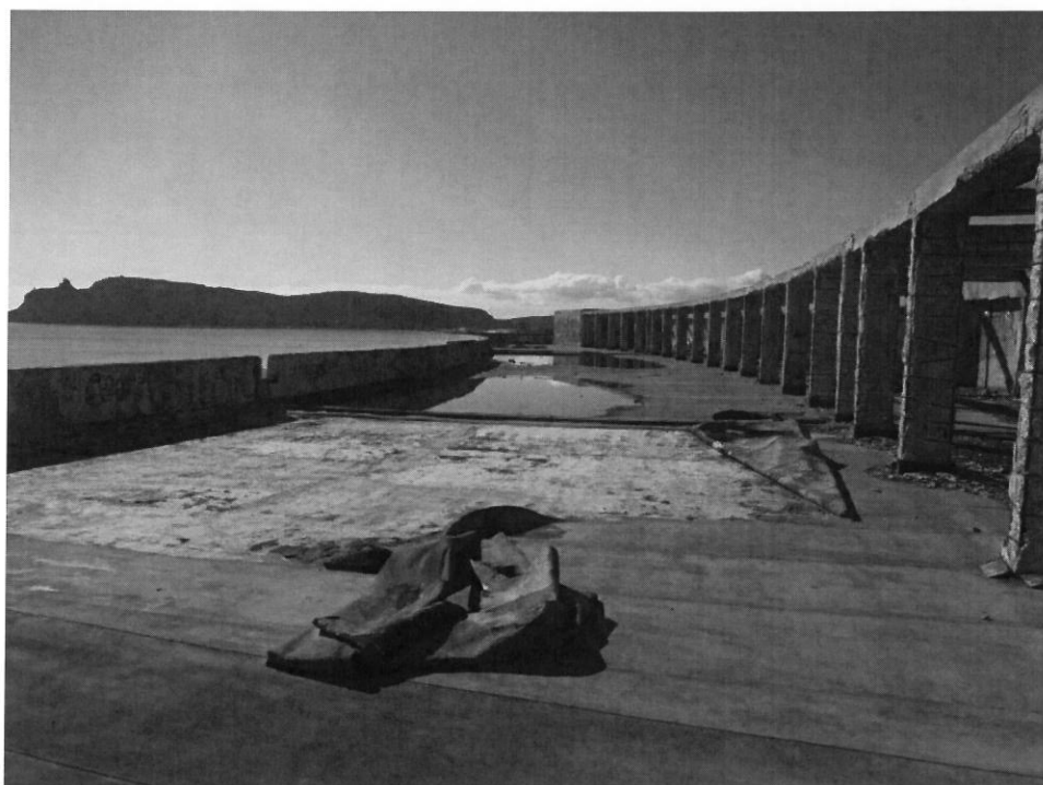
Terrazza di copertura, stato del manto impermeabilizzante e rapporto della struttura col paesaggio circostante
