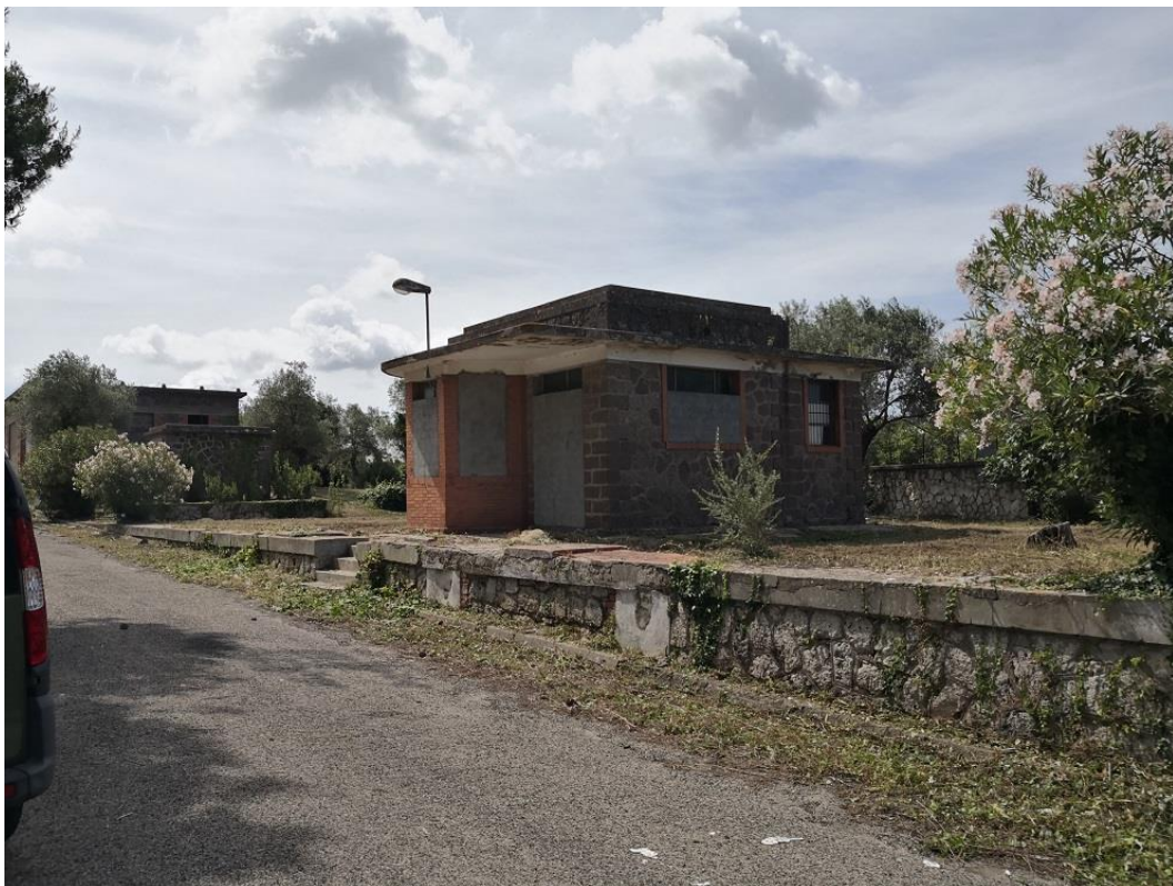
Vista area di intervento
