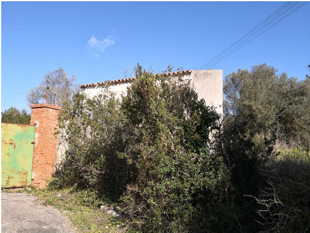
Vista area di intervento
