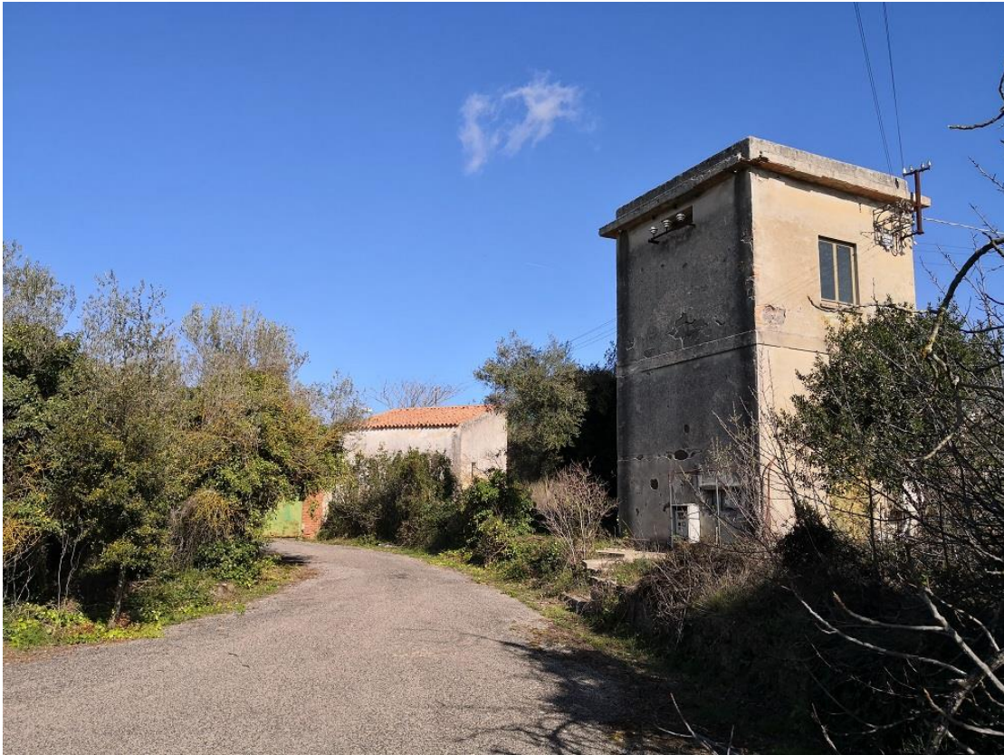
Vista area di intervento
