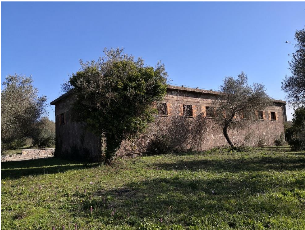
Vista area di intervento
