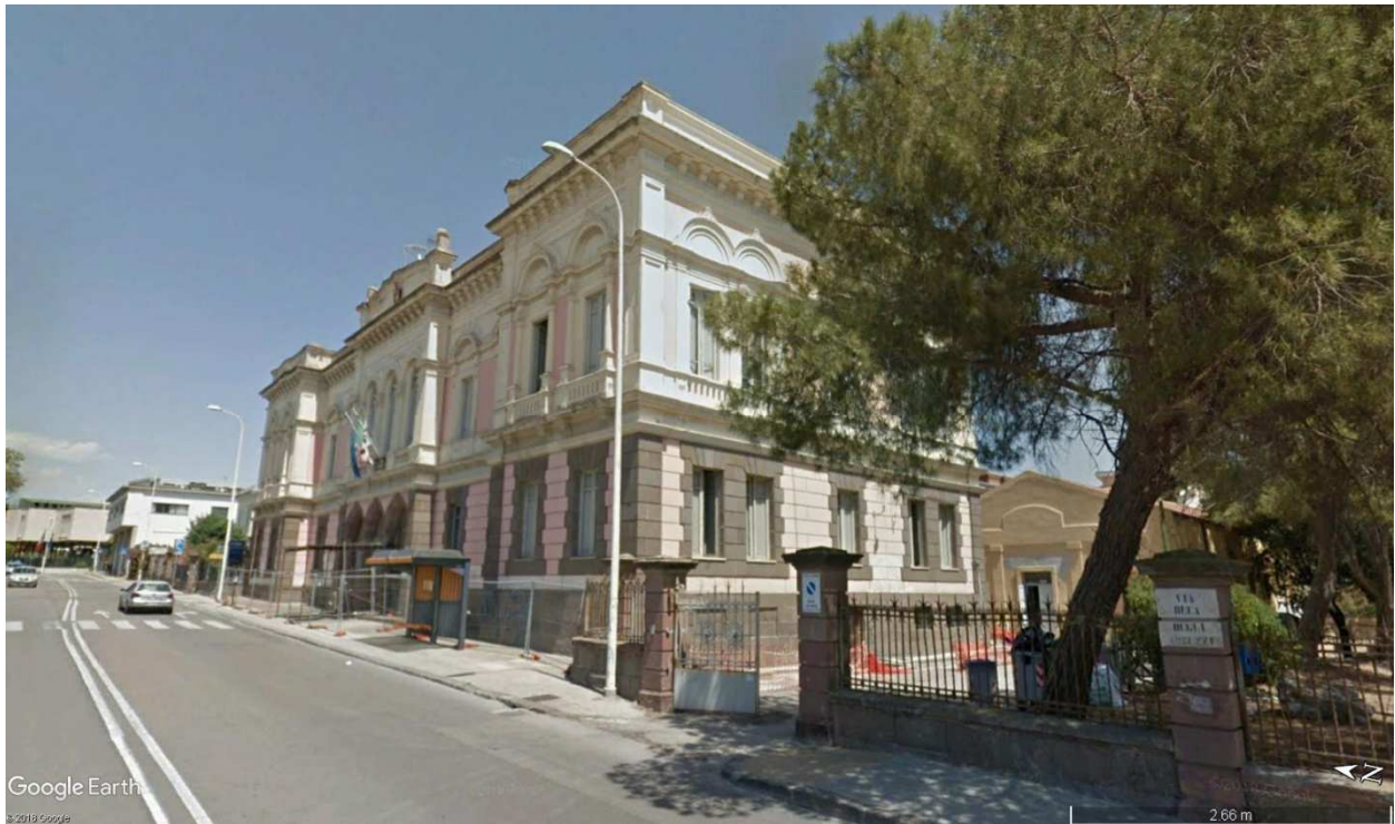
Facciata dell'edificio principale in affaccio sulla Via Duca degli Abruzzi
