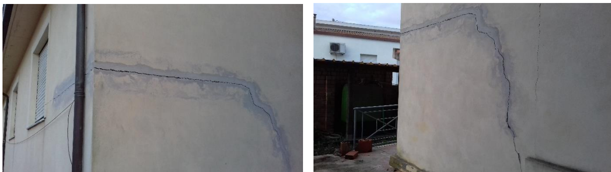
Figura 1 – Lesione spigolo nord-ovest
