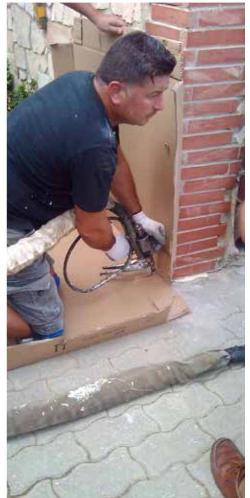
Iniezione resina espandente
