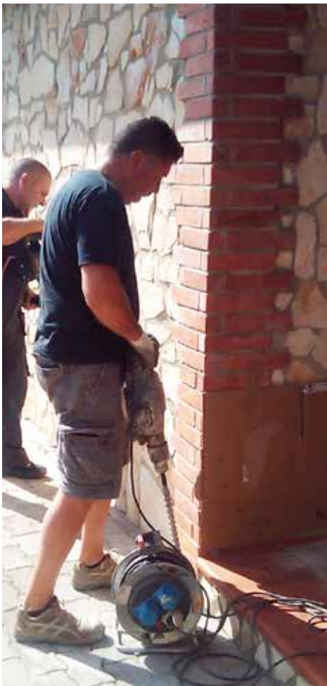
Perforazione della fondazione
