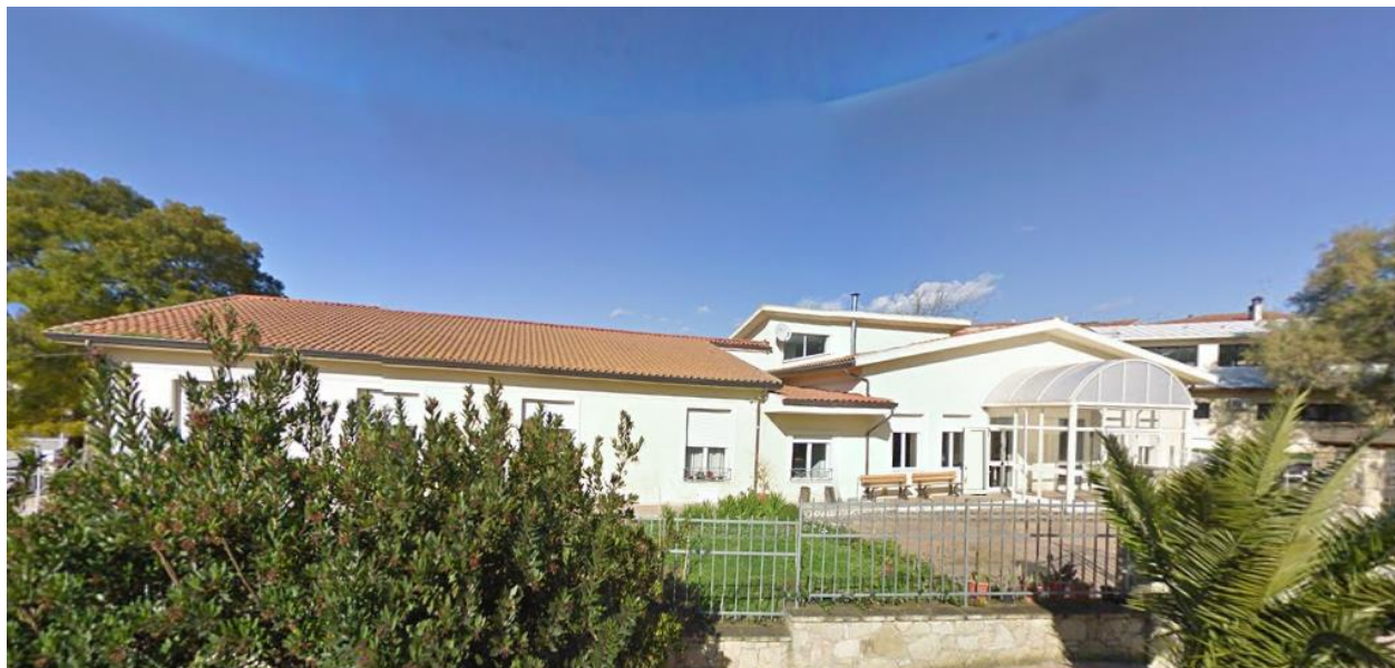
Figura 4: Prospetto principale su via Risorgimento
