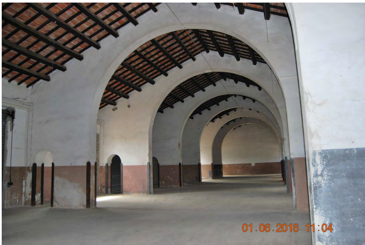
Figura 37 - vista del fabbricato n°4
