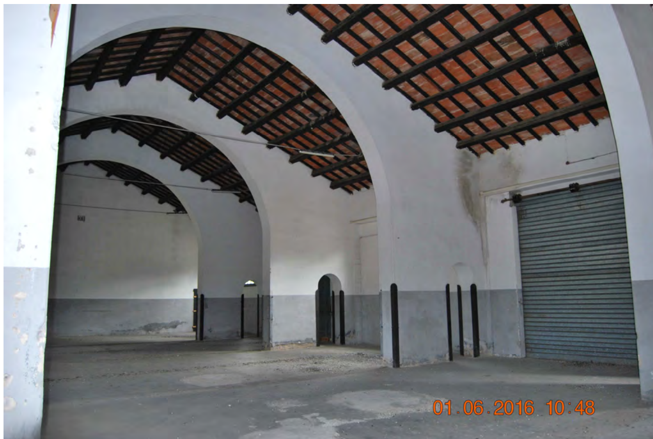
Figura 42 - vista del fabbricato n°7
