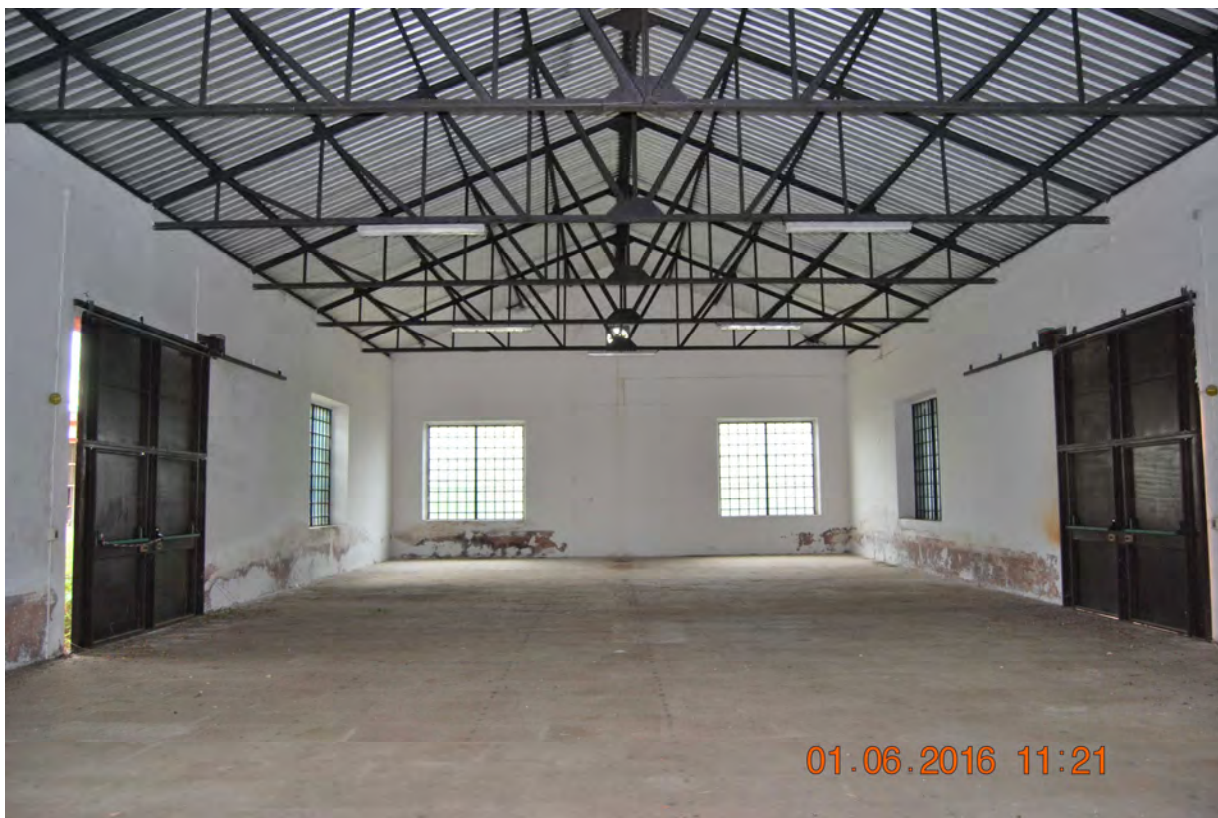
Figura 33 - vista del fabbricato n°3
