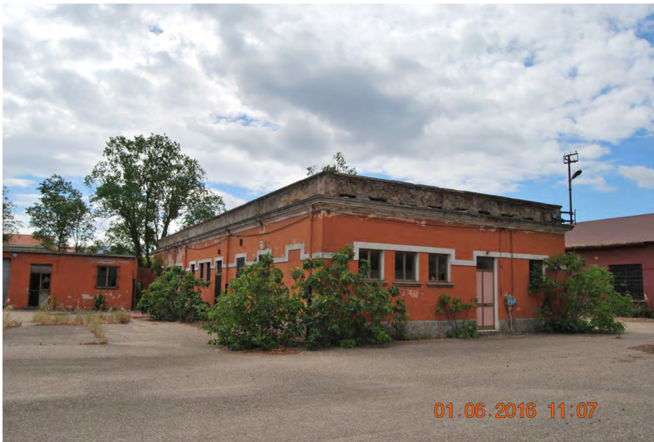
Figura 31 - vista del fabbricato n°2
