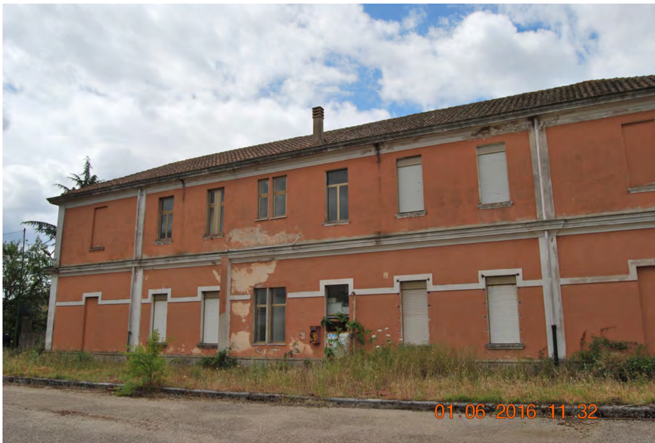
Figura 27 - vista del fabbricato n°1
