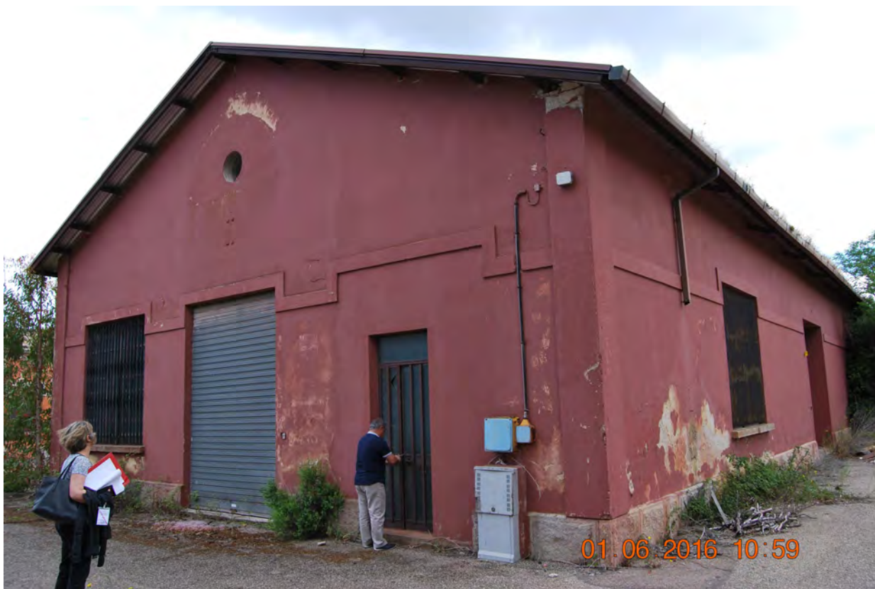
Figura 32 - vista del fabbricato n°3
