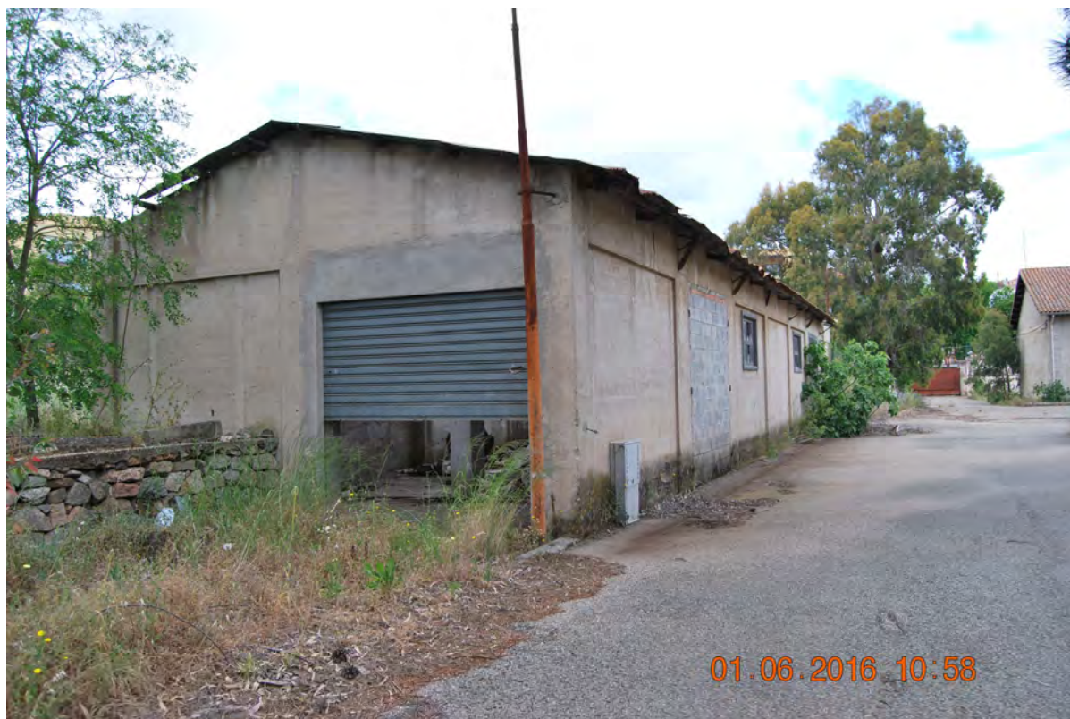
Figura 44- vista del fabbricato n°15
