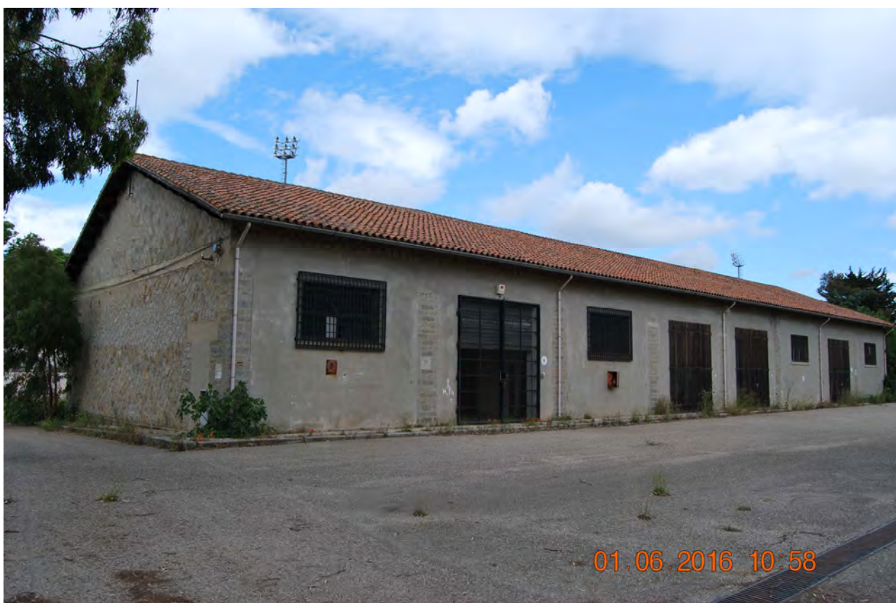
Figura 41 - vista del fabbricato n°7
