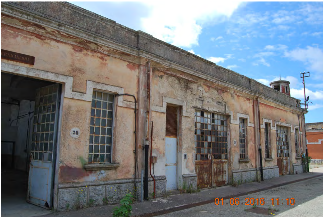
Figura 29 - vista del fabbricato n°1
