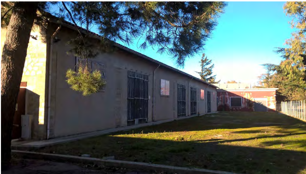
Figura 35- vista del fabbricato n°4
