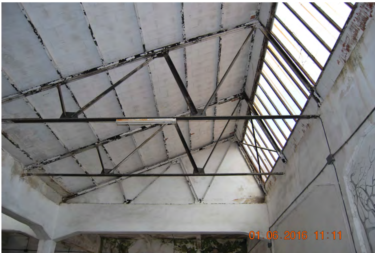
Figura 30 - vista del fabbricato n°1
