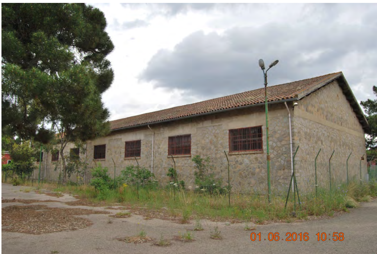
Figura 34 - vista del fabbricato n°4
