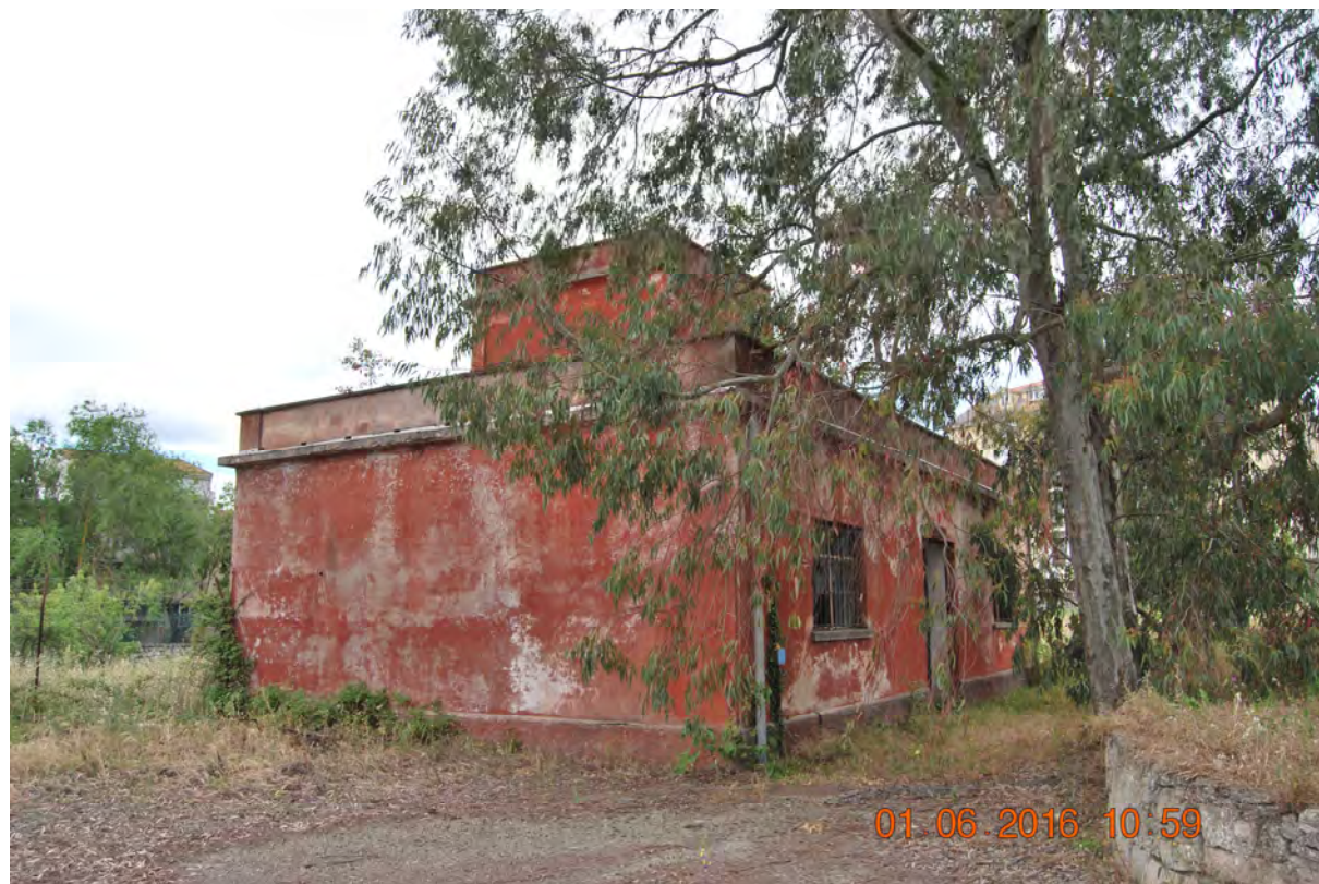
Figura 43- vista del fabbricato n°14
