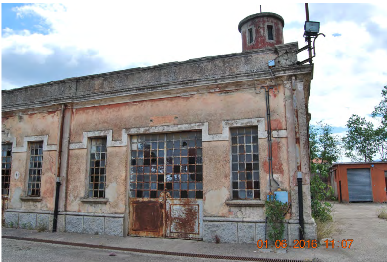
Figura 28 - vista del fabbricato n°1
