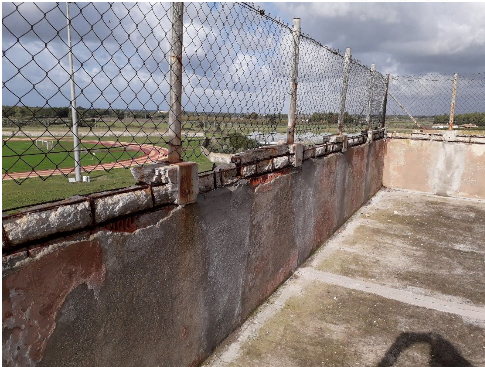
Foto 3. Dettaglio parapetto degli spalti del campo in terra battuta e scorcio del campo in erba adiacente e della pista di atletica
